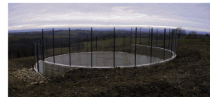
Fosse de stockage 200 m3
